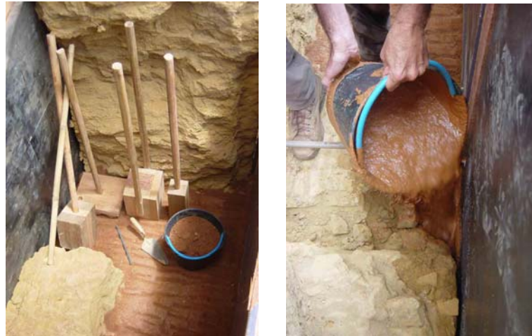
Figura 2 - Inovação e tradição na elaboração da Super-Taipa: a) pilões utilizados durante a execução da nova estrutura em taipa; b) lama líquida reforçada com fibras e dispersão de A. P. nas fissuras verticais da taipa histórica
